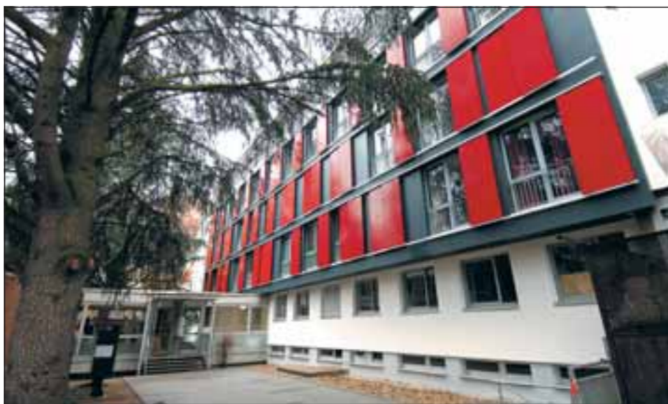
Mit einer „Grauwasseranlage“ hinter einer bunten Fassade und neuer Wärmedämmung erfüllt das Comeniushaus hohe Umweltstandards. Foto: Stefan Kresin
